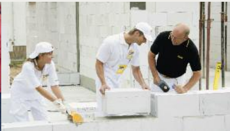
■ So wird für viele der Alltag auf der Baustelle sein: Umsetzen, was man im Kurs gelernt hat.
